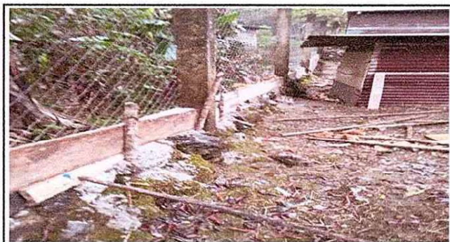
foto 3. formateado previo para el muro
