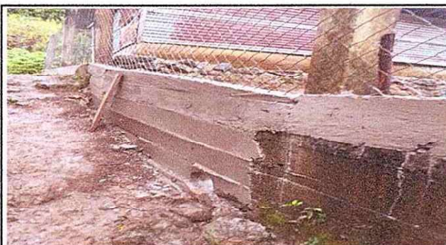
foto 4. proceso de secado del muro
