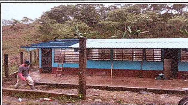
foto 2. instalacion de la cubierta de lamina
