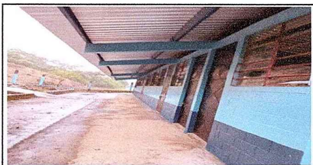
foto 5. inicio del cambio de los vidrios y pintura
